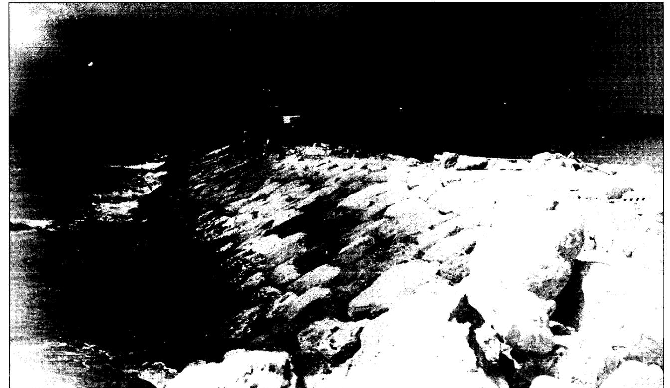
Fotografía 1.- Perspectiva y aspecto general de la colocación careada y concertada de la arenisca calcárea en el manto exterior del talud del espigón de la playa de La Costilla (Rota).
